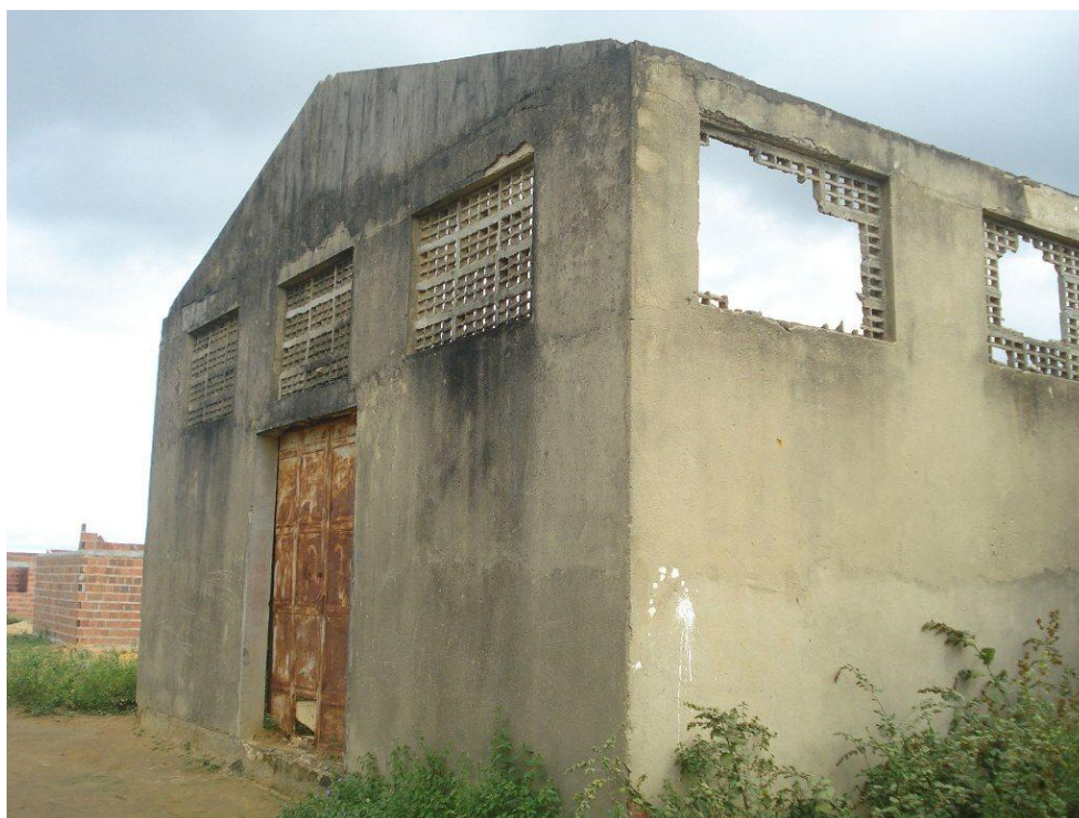
FOTO 20 – Galpão abandonado - Povoado Alto do Capim
