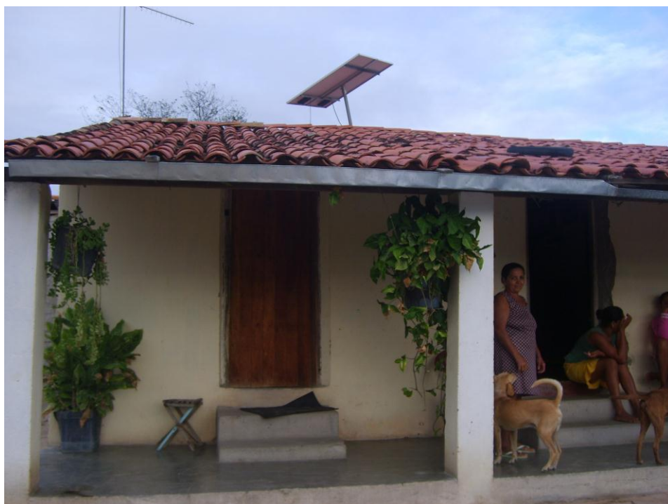
FOTO 12 – Energia Solar – Fazenda Capitão
