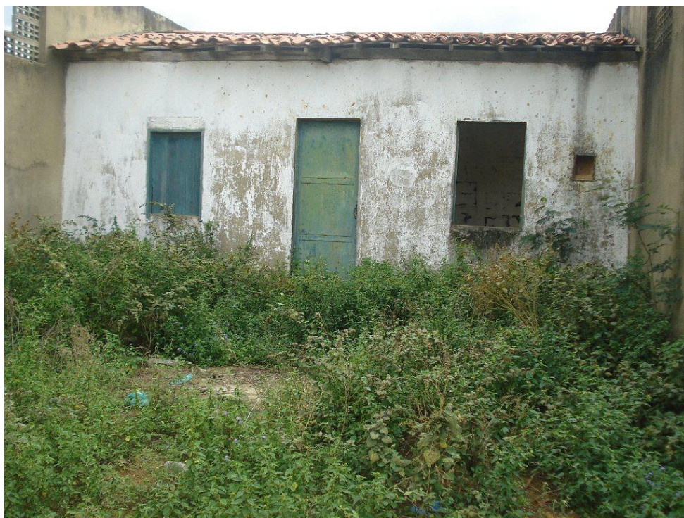
FOTO 19 – Galpão abandonado - Povoado Alto do Capim
