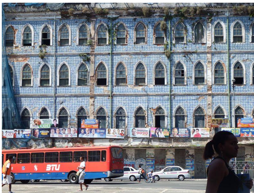
FIGURA 21: Fonte Djane Rangel – visita técnica a Praça Cairú – Prédio onde funcionou o supermercado
