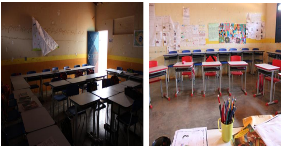
Figura 10 - Ambiente interno da sala de aula
