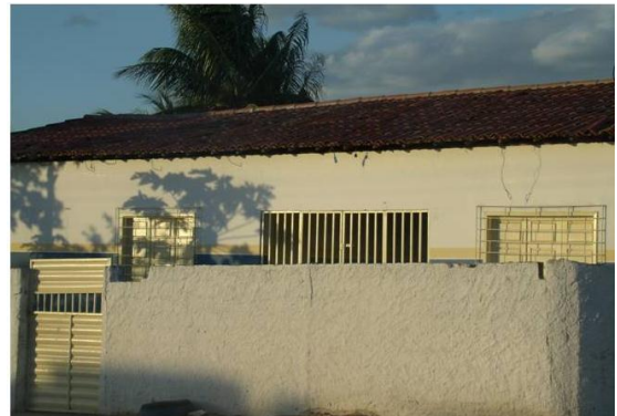
Imagem 6: Fachada externa da EMMMR – Povoado de Morro Fonte: Arquivo pessoal da pesquisadora
