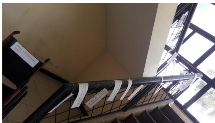
Figura 9 – Escada que dá acesso à sala da oficina (1º lance)
