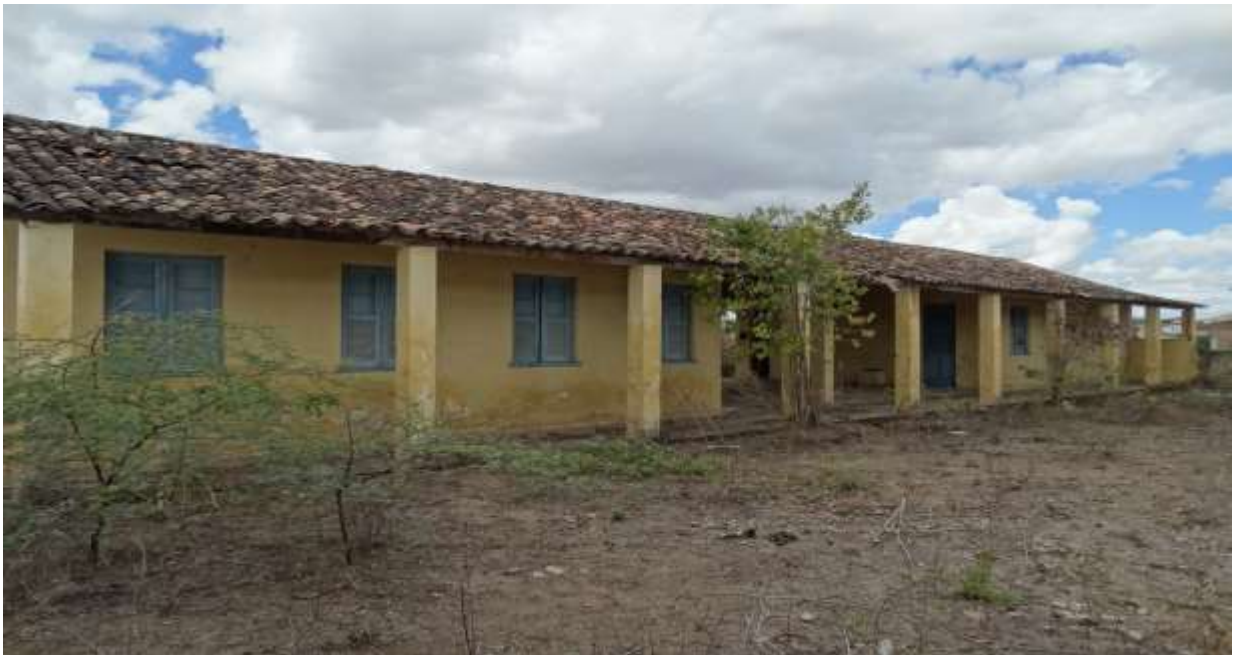
Figura 05 – Prédio Rural de Ichu
