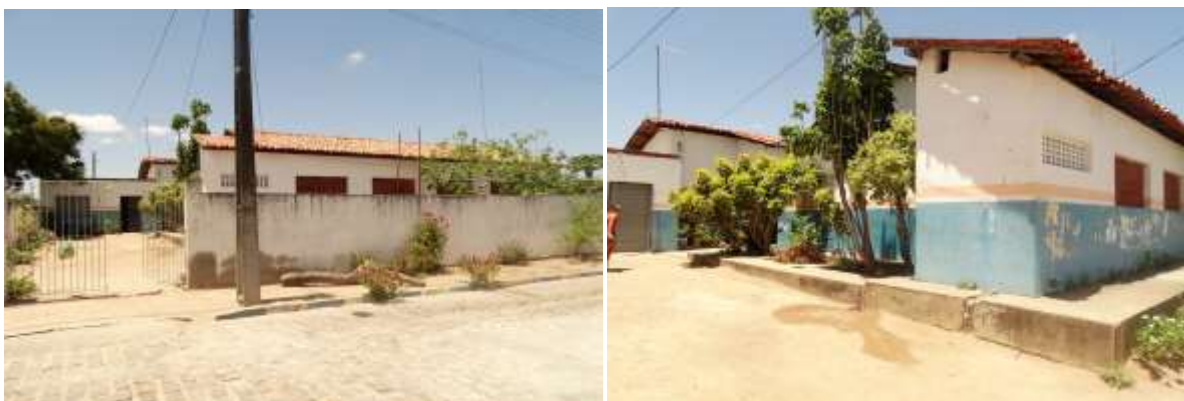
Figura 13- Prédio Escolar de Vila Guimarães
