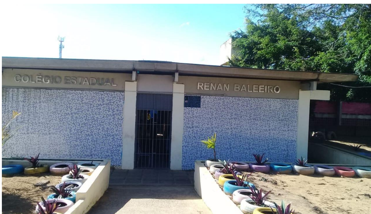
Figura 7: Fachada do Colégio Estadual Renan Baleeiro na atualidade.
