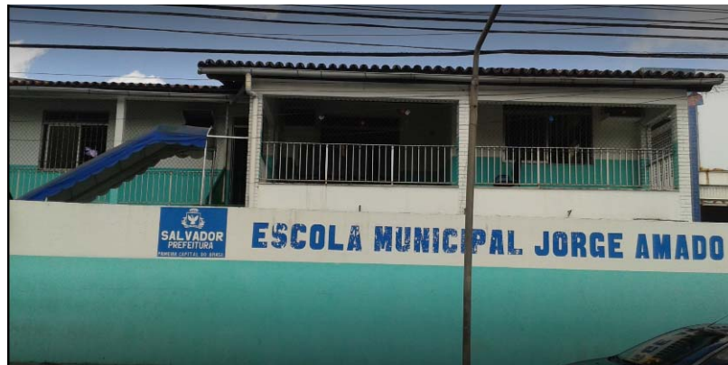
IMAGEM 08: Fachada da Escola Municipal Jorge Amado
