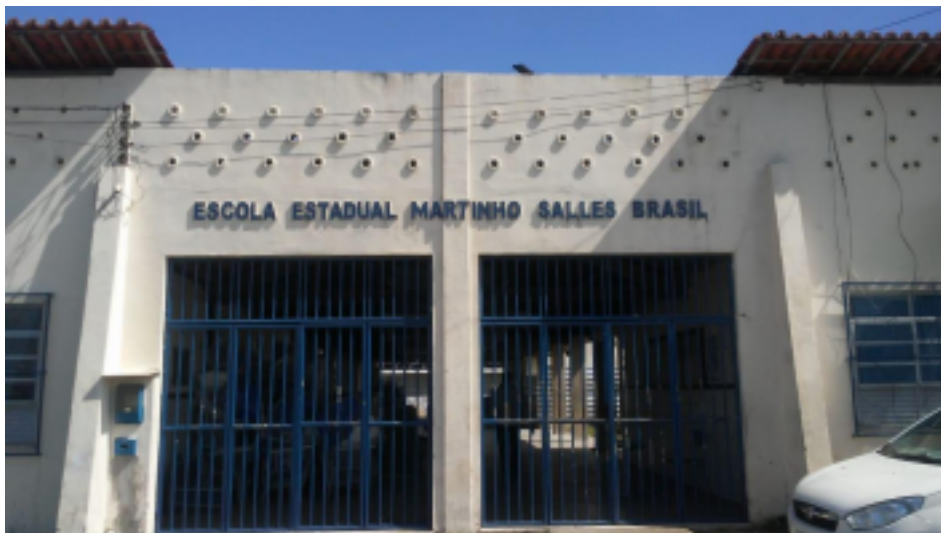
Figura 3 – Fachada do Colégio Estadual Martinho Salles Brasil
