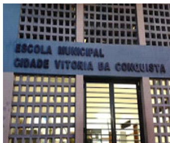
Figura 5: Fachada da EMCVC após reconstrução e inauguração, em 2006.
