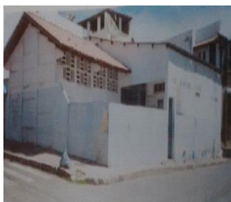
Figura 4: Fachada da EMCVC em 1958.
