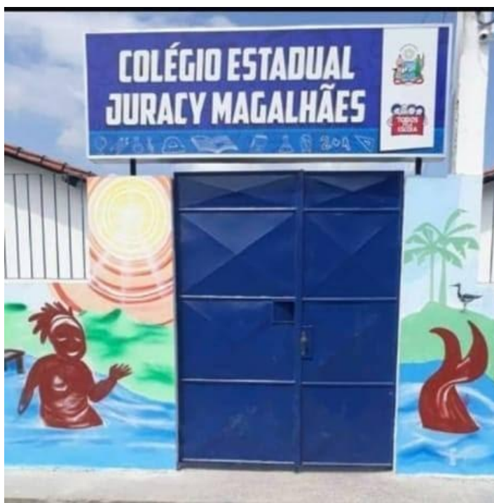
Figura 3 - Fachada do Colégio Estadual Juracy Magalhães
