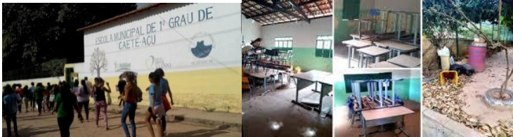
Anexo do Colégio Nilde Maria Monteiro Xavier, no Vale do Capão Fonte: Google (2019)
