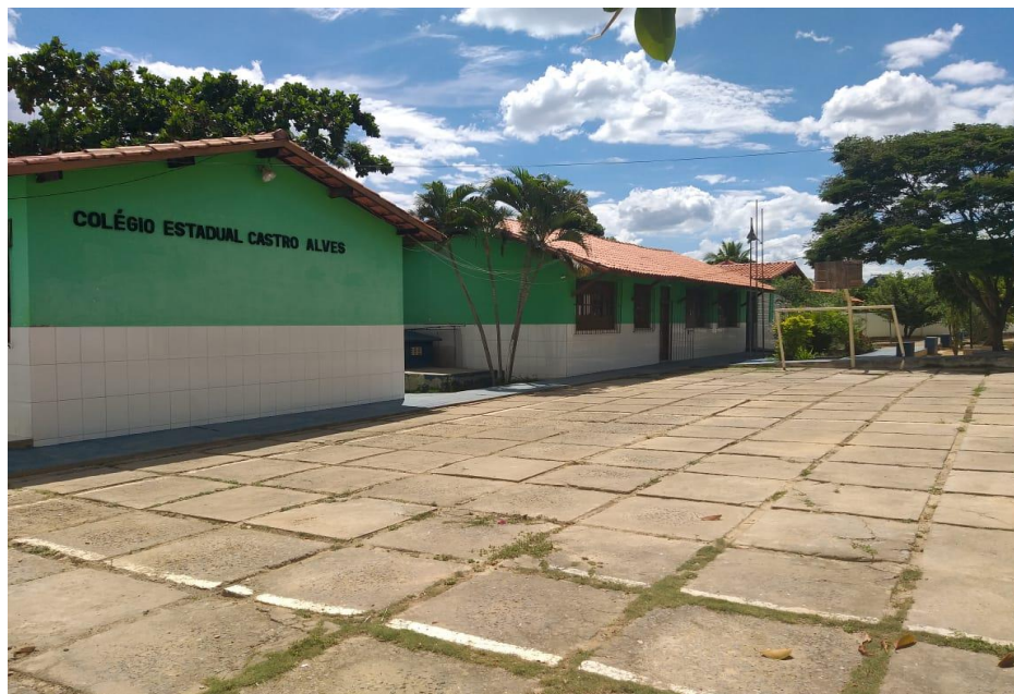
Figura 04 – Colégio Estadual Castro Alves em Novo Horizonte – Bahia
